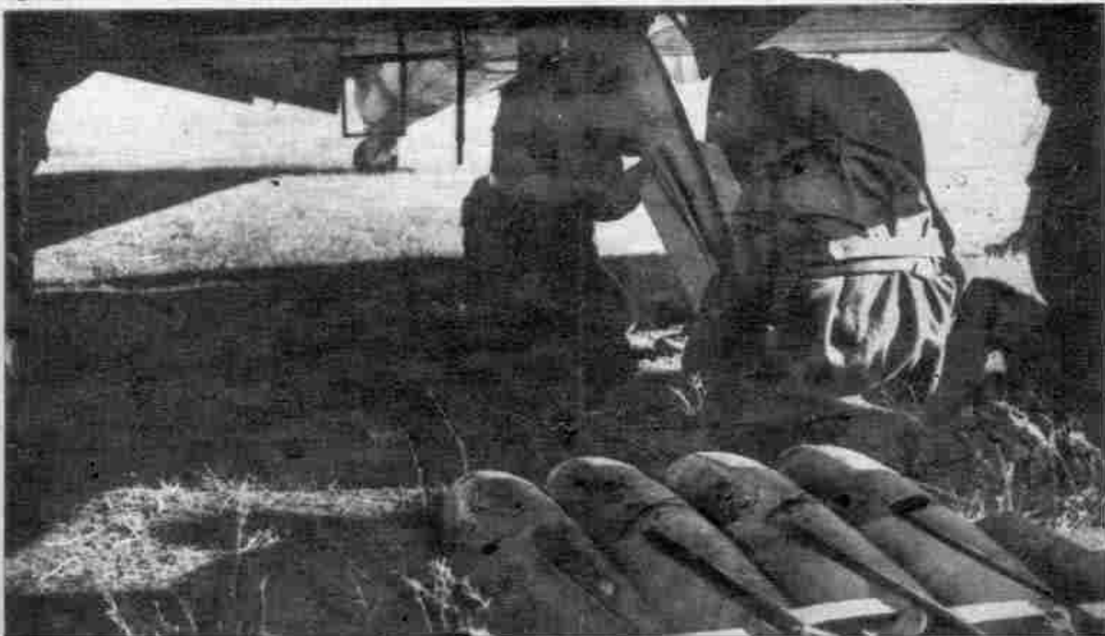
Instalarea bombelor. (S. M. P.)
