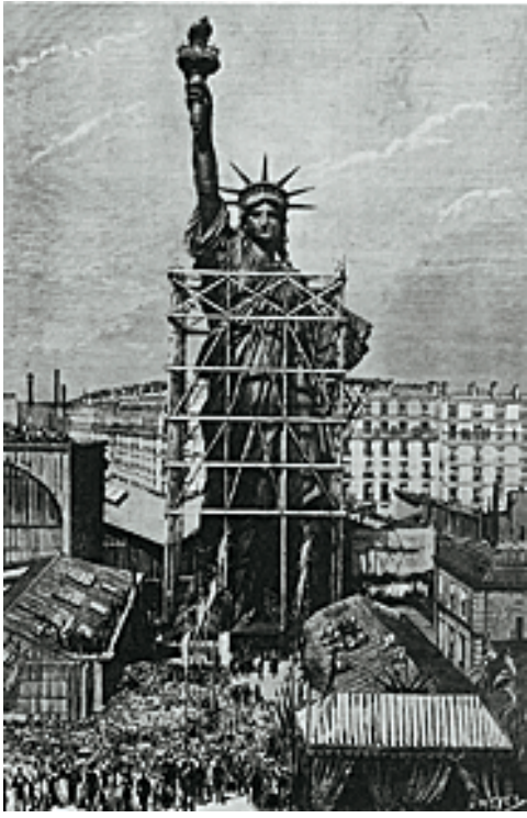
Монтаж статуи Свободы.
